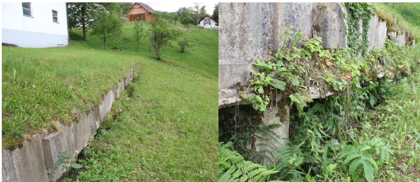
Slika 2 in 3 prikazujeta posedanje terena pod pilotno steno
