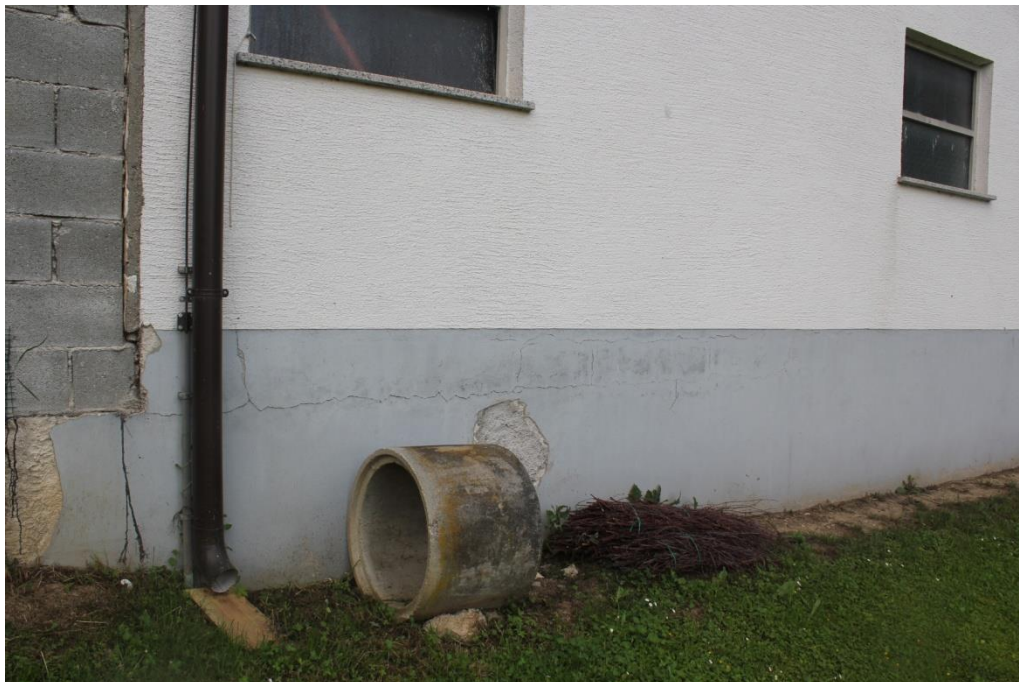
Slika 5 Pogled na poškodbe na SZ strani objekta, kjer se vidi vertikalno posedanje.
