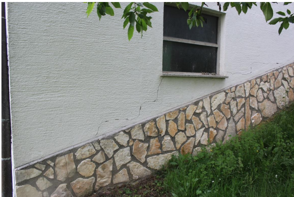
Slika 6 Pogled na poškodbe na JZ strani objekta, kjer se strižna razpoka.
