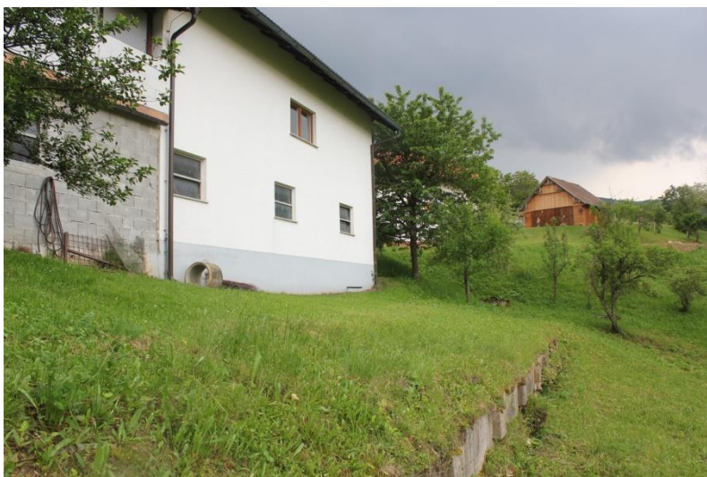
Slika 1 Pogled na izvedeno pilotno steno in objekt Zagorje 39
